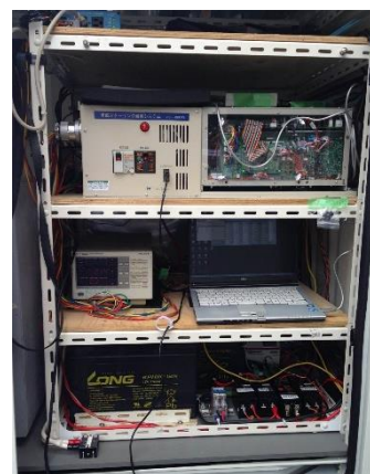
コンバータ(上段), パワーメータとノートPC(中段), バッテリとソーラー発電コントローラ(下段)
